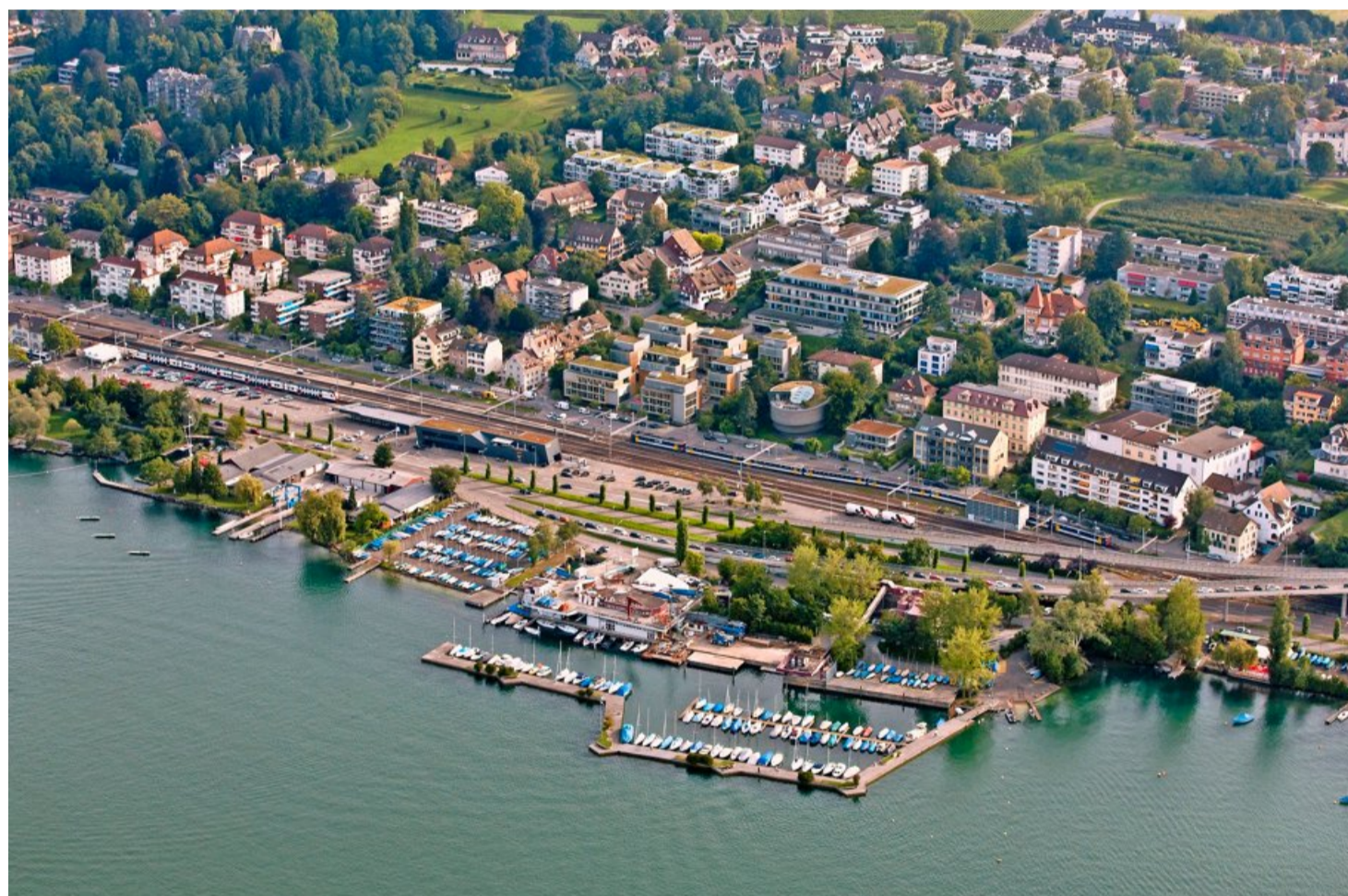
Der heutige Hafen bei Zürich-Tiefenbrunnen entstand 1979 als Umschlagplatz der Kibag AG.
