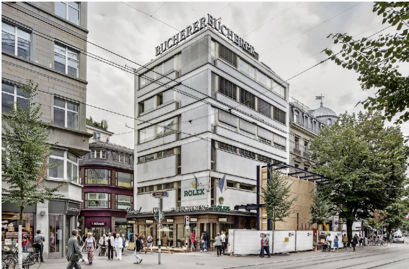
So ist es heute: Das Haus aus dem Jahr 1961, das nur mit einer Ausnahmebewilligung gebaut werden konnte. Foto: Dominique Meienberg
